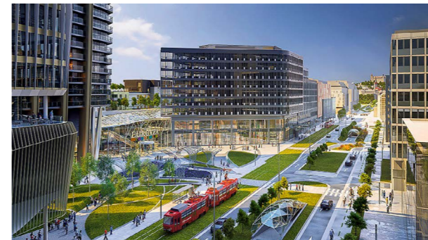
Električková trať – nový okruh, ktorý od Starého mosta prejde cez Euroveu a Dulovo námestie až na Miletičku.
