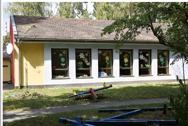
V Mierovej kolónii sme prevzali budovu od súkromníka, ešte tento rok tam otvoríme škôlku.
