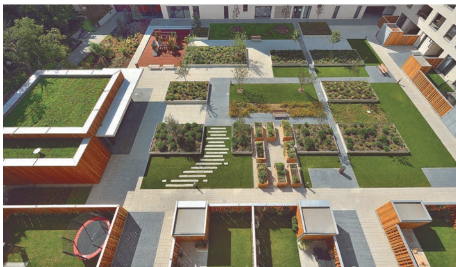
Pohľad na vnútroblok nad podzemnou garážou, začiatkom leta 2018.
