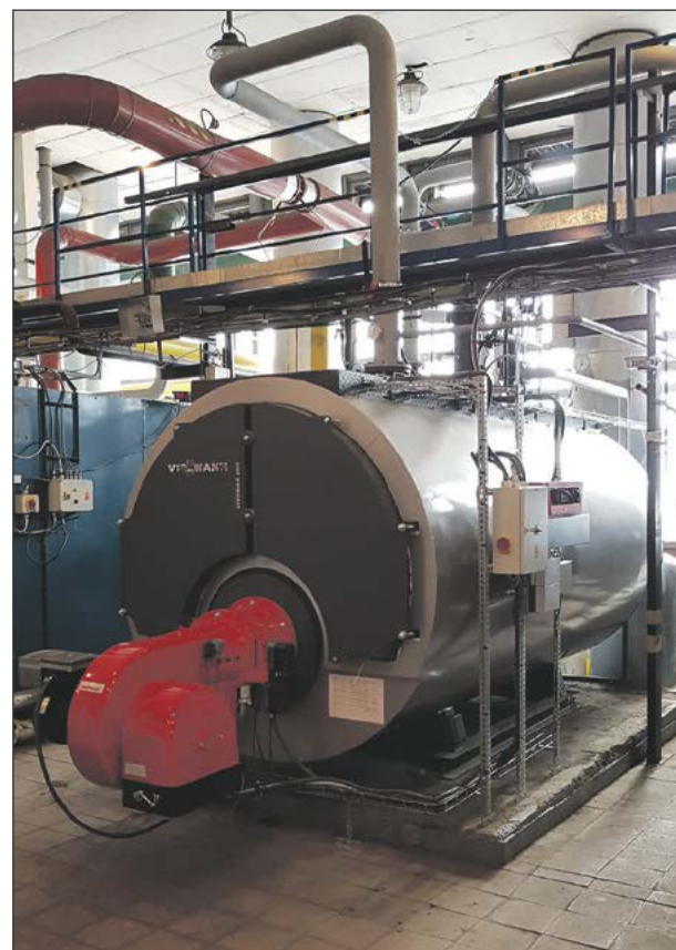
Moderný plynový kotol s rekuperáciou tepla spalín
