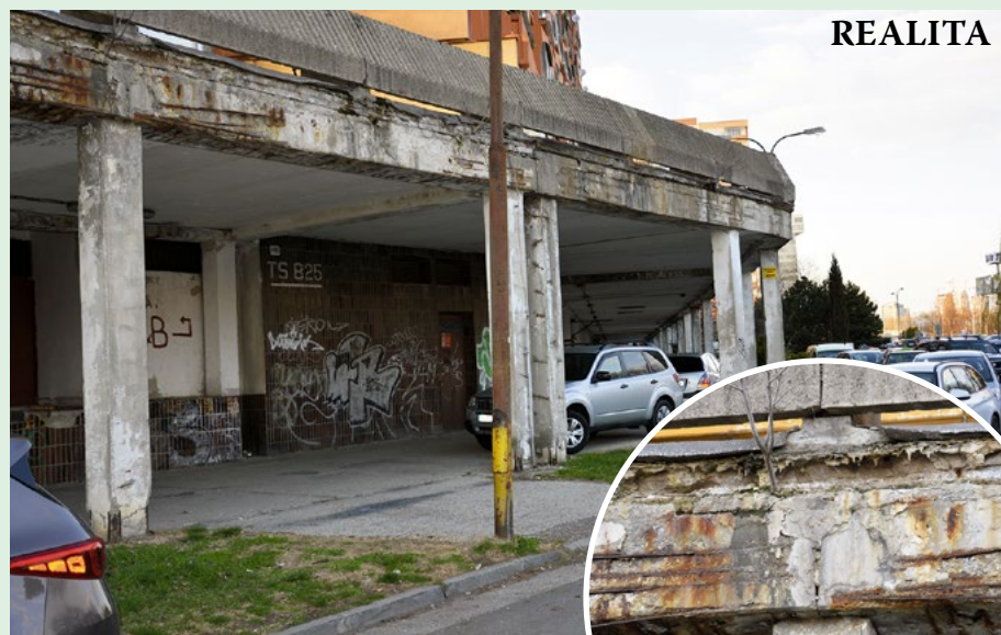
Spoje skeletu nejednej terasy v Petržalke sú v dezolátnom stave.
