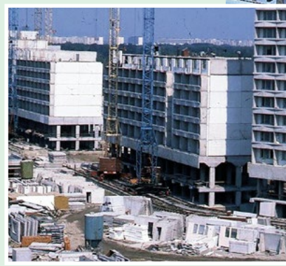
◀ Z výstavby domu v Petržalke pred osadením konštrukcie terasy.
