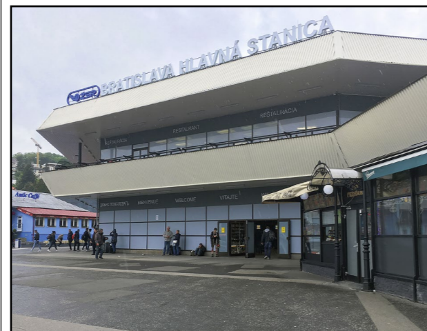
Hlavná železničná stanica nevyhnutne potrebuje modernizáciu.
