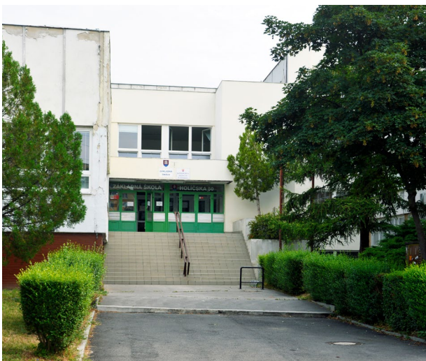
▲ Na ZŠ Holičskej sa rekonštruujú toalety a kuchyňa.
