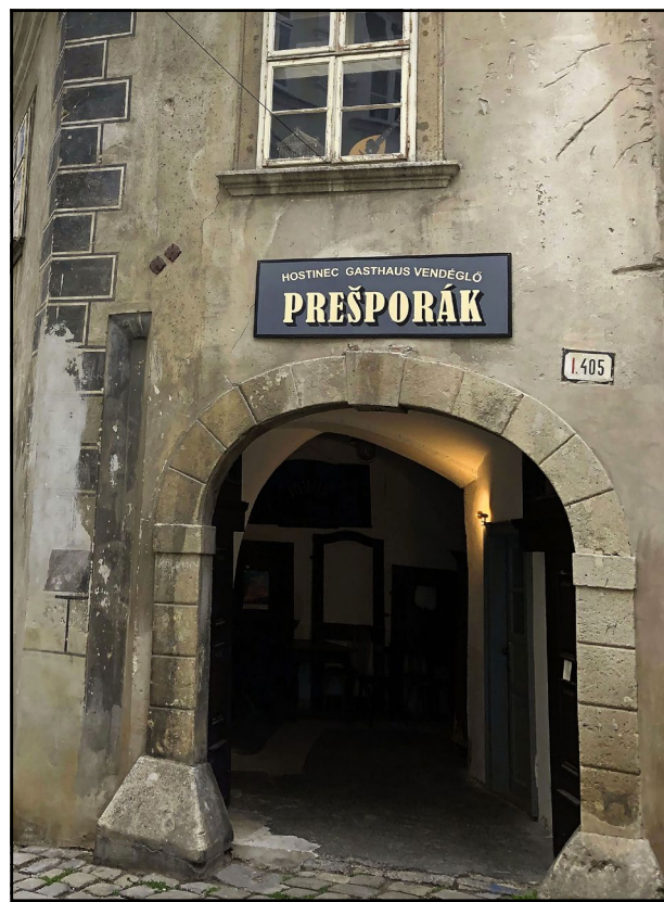
Rodný dom F. F. Rómera na Zámočnickej ulici v Bratislave.
