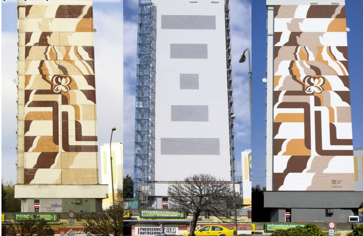
Malba Mier na Osuského ulici od Jozefa Porubčína pred a po zateplení domu v roku 2015.
