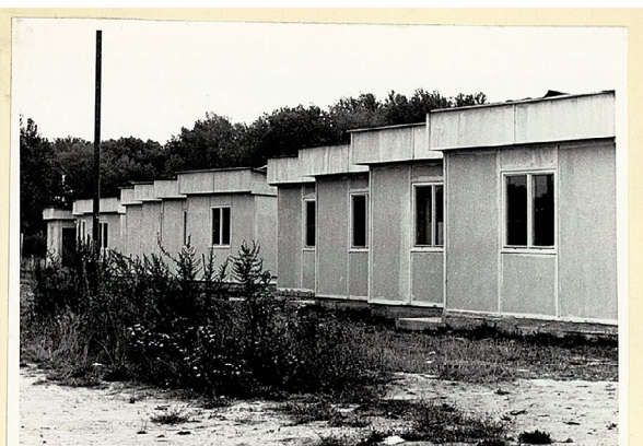
VÝSTAVBU BALČICH 12 CHATIEK V AKCII „ZVELADENIA“ A OBYČIENIA V AUTOCAMPINGU „ZRKADLOVÝ HÁJ“ SA ROZŠÍRILI UBYTOVACIE MOŽNOSTI PRE MOTOTURISTOV.
