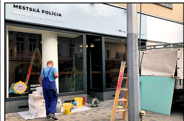
Niekoľko dní po otvorení stanice stavbári ešte odstraňovali menšie nedostatky.
