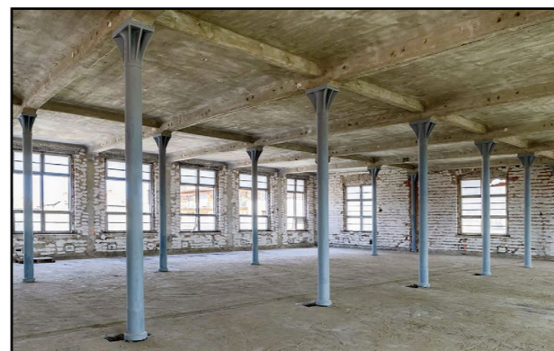
Rekonštruujú sa všetkých 403 liatinových stĺpov a 1 betónový stĺp.
