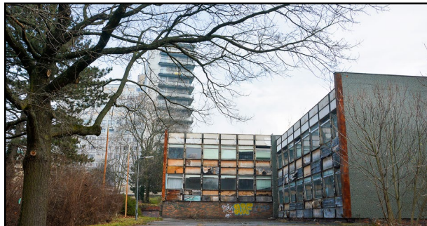
Chátrajúca budova je priamo v nemocničnom areáli.
