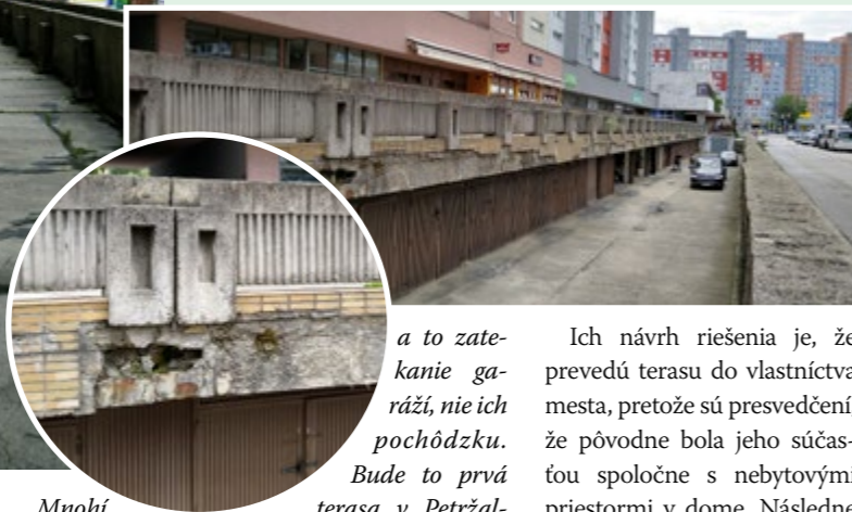
Pre garážnikov nepotrebné zábradlie, ktoré odpadávaním obkladov poškodzuje vozidlá a umožňuje zatekanie vnútorných priestorov garáží.
