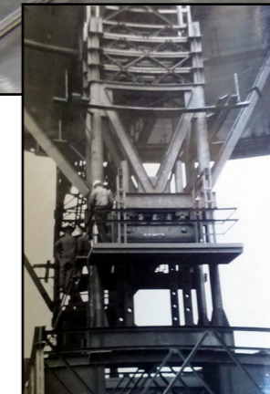
Zdvíhací systém bol vytvorený na princípe teleskopu.
