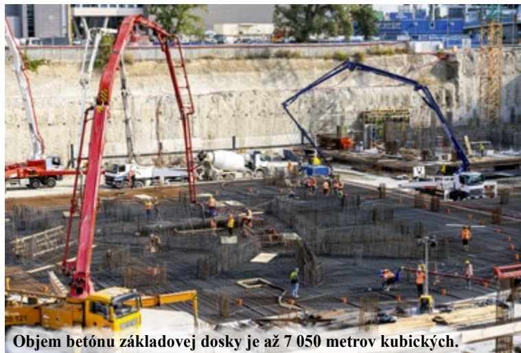
Stavbári pred začiatkom betónovania naviazali oceľovú betonársku výstuž s celkovou hmotnosťou 1 880 ton.
