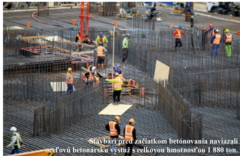
Objem betónu základovej dosky je až 7 050 metrov kubických.
