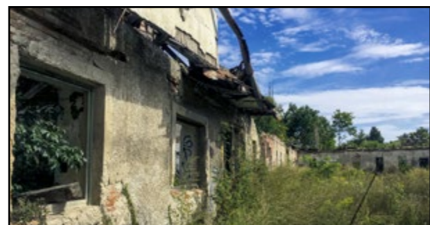
Smutný je aj pohľad na chátrajúci čeládnik.
