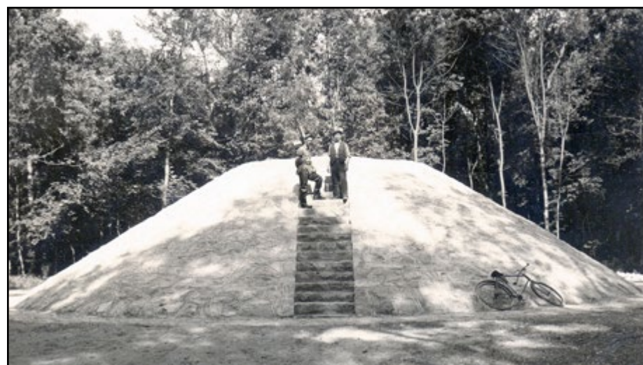
Prvá vodárenská studňa na Sihoti je dnes národnou kultúrnou pamiatkou.
