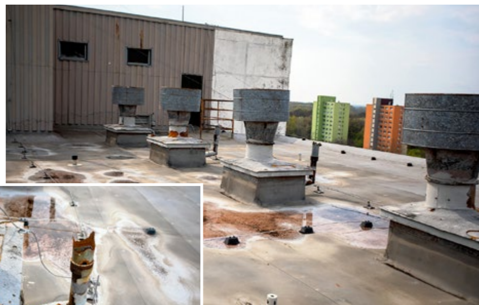
▲ Strecha sa roky len plátala, je preličená, s mlákami vody, zhrdzavenými odtokmi...
