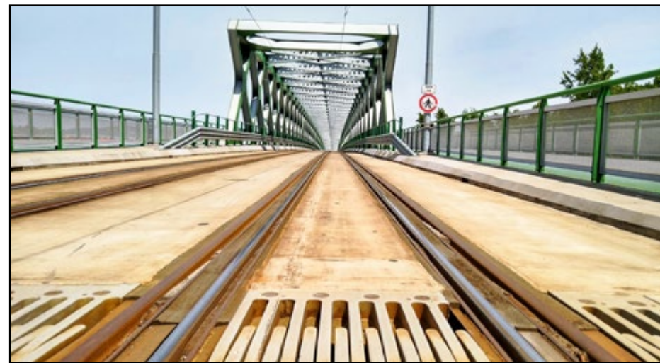
Popri užších električkových koľajniciach sú natiahnuté železničné s rozchodom 1 435 mm. Zbytočné...
