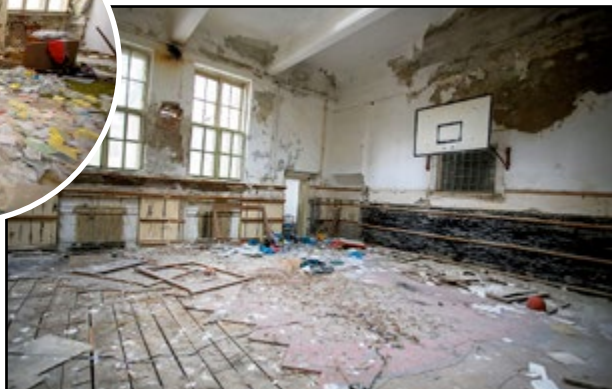
V bývalej telocvični má byť po obnove archív okresného súdu.
