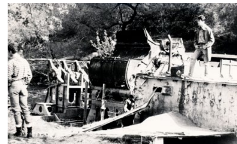
▲ „Na fotografii, ktorú som stihol odfoťiť ešte pred definitívnym rozkradnutím, sú zvyšky strojovne - vľavo základy parného stroja a vpravo zvyšky lodného parného kotla,“ hovorí Juraj Bohunský.
