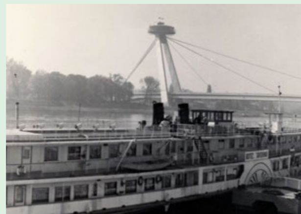
▲ Parník Bratislava na lodnom výtahu v južnom bazéne bratislavského Zimného prístavu pred vytiahnutím a ošetrením podponorovej časti.
