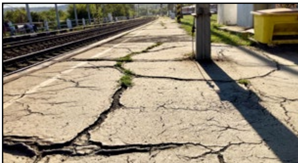
Z opravy povrchu nástupísk asfaltovaním nakoniec zišlo.
