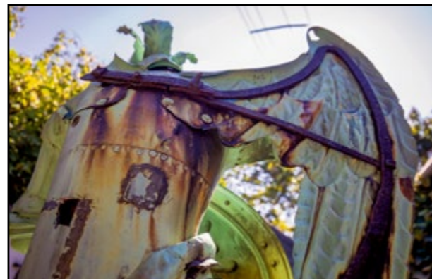
Podporná konštrukcia na viacerých miestach skorodovala.
