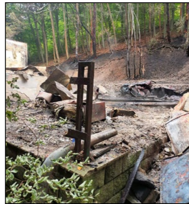
Ruina bývalého rekreačného strediska Verona na Železnej studničke, ktoré zhořelo.
