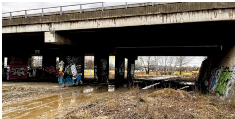
▲ Hrubú stavbu stanice metra Janíkov dvor a 300 metrov dlhý úsek traťového tunela metra búrajú, nahradí ich električková trať.
