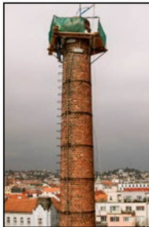
Komín je už zrekonštruovaný.
