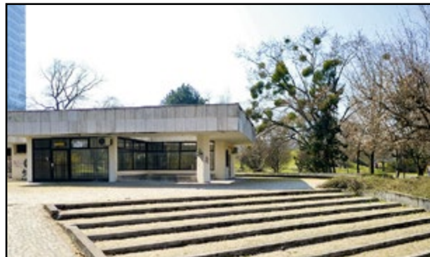
Prvé práce na obnove budovy by sa mohli začať už v priebehu leta.
