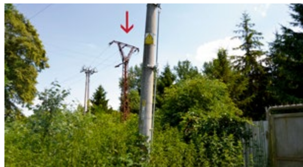
▲ Oceľový stožiar elektrického vedenia (vyznačený červenou šípkou), ktorý dnes stojí v miestach, kde sa mal hrob nachádzať
