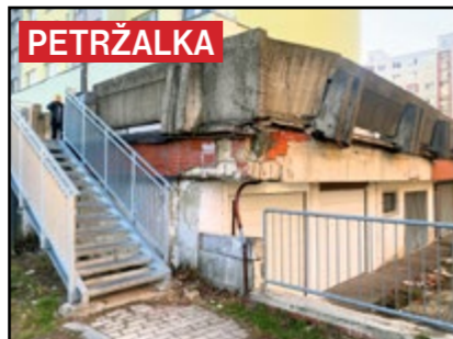
Na nebezpečne sa nakláňajúce zábradlie upozorňovali mnohí.
