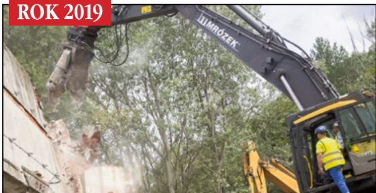
Začína sa s búraním komplexu budov.
