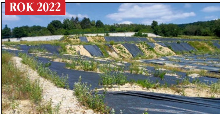
„Kaskádovitý“ terén po odstránení základovej dosky
