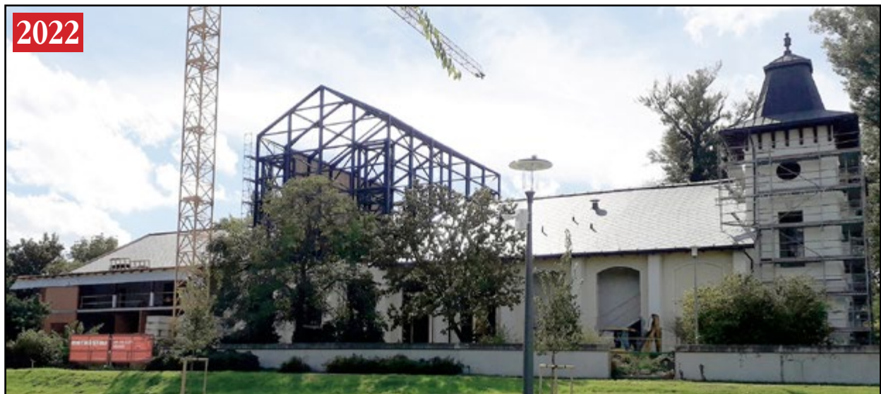
Konštrukcia budúcej veže povraziska, ktorú malo divadlo do roku 1939.
