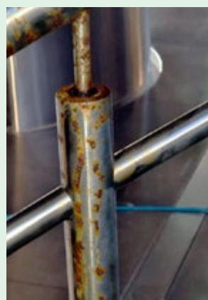
Hrdza na nosných stĺpoch, stav niektorých svetidiel, stav zábradlí v bazénovom priestore a kuchynské vybavenie... Aj takto chátrala plaváreň.
