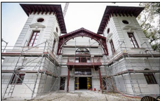
Reštaurátorské práce na oboch vežiach pri hlavnom vstupe sú už ukončené.
