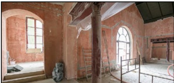
Po osadení okien a dokončení strechy sa práce sústredia na obnovu interiéru.
