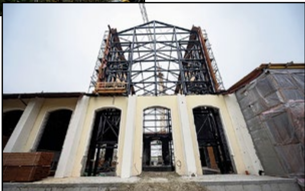
Oceľová konštrukcia budúcej veže povraziska. Divadlo ju malo aj v minulosti.
