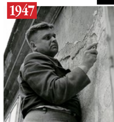
Alfred Piffel pri renovovaní budovy na rohu Rybnej brány a Laurinskej ulice.
