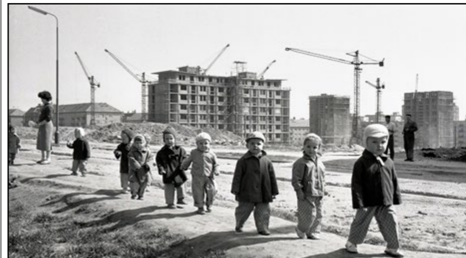
Sídlisko bolo po dokončení kompletne vybavené, nechýbali školy, škôlky, ihriská, obchody služby...
