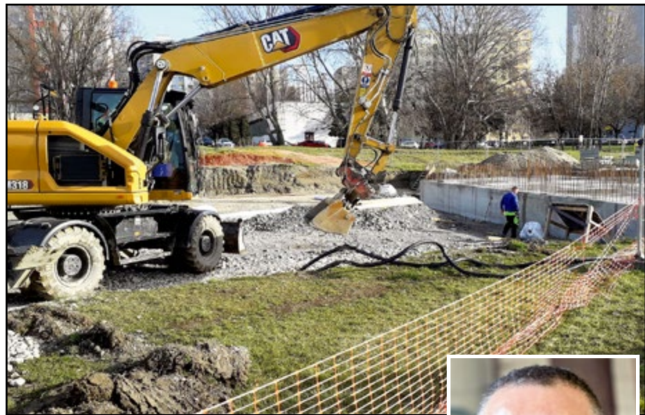
Práce na predĺžení električkovej trate majú značné zdržanie, postupujú pomaly.
