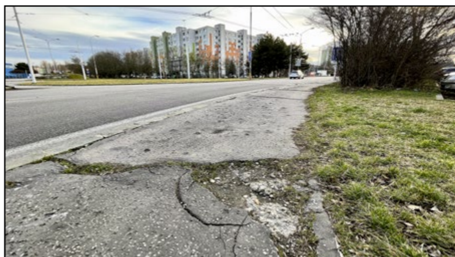
Cestu na Kazanskej i Dvojkřížnej opravili, chodník len na vybraných úsekoch.
