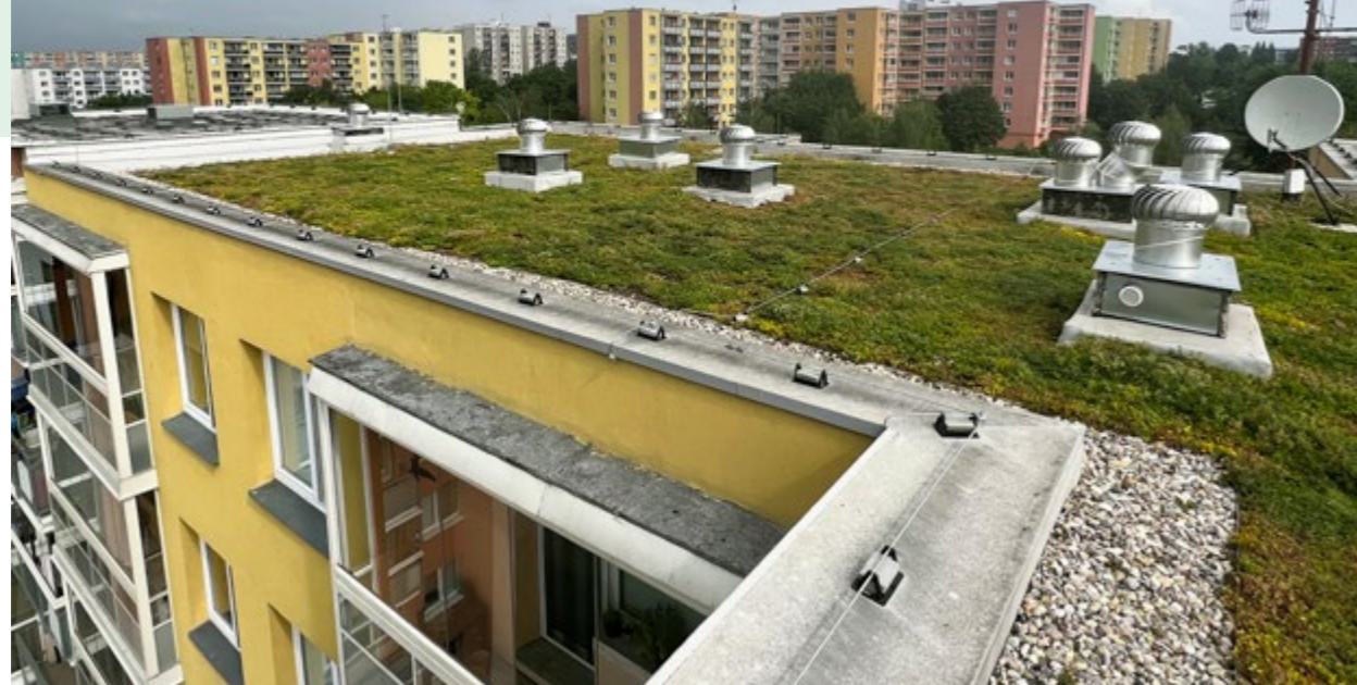
▲ Zelená strecha na bytovom dome v Brne - Bohuniciach. Bola odľahčená kvôli statike. „Toto je cesta aj pre petržalské staré bytovky,“ hovorí Branislav Siklienka, ktorý bol v porote českej zelenej strechy roka.
