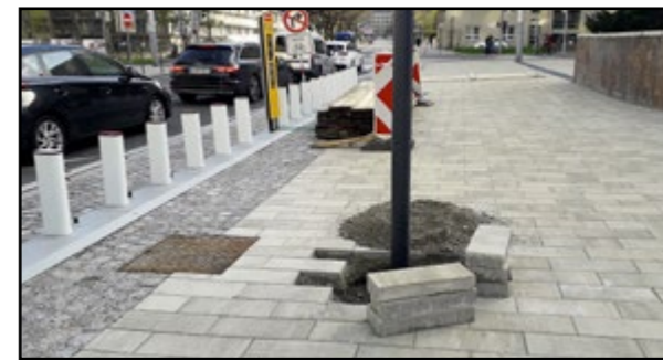
Novú dlažbu na niektorých miestach rozobrali kvôli inštalácii verejného osvetlenia (foto z 20. apríla).
