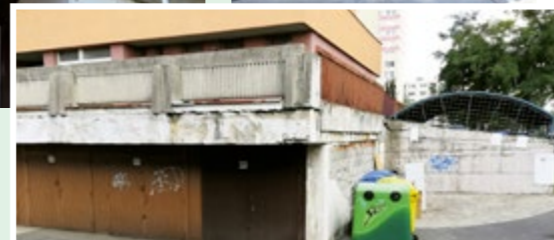
Svojpomocne vyrobený odvod dažďovej vody z terasy.
