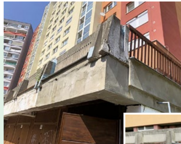
Svojpomocne vyrobený odvod dažďovej vody z terasy.
