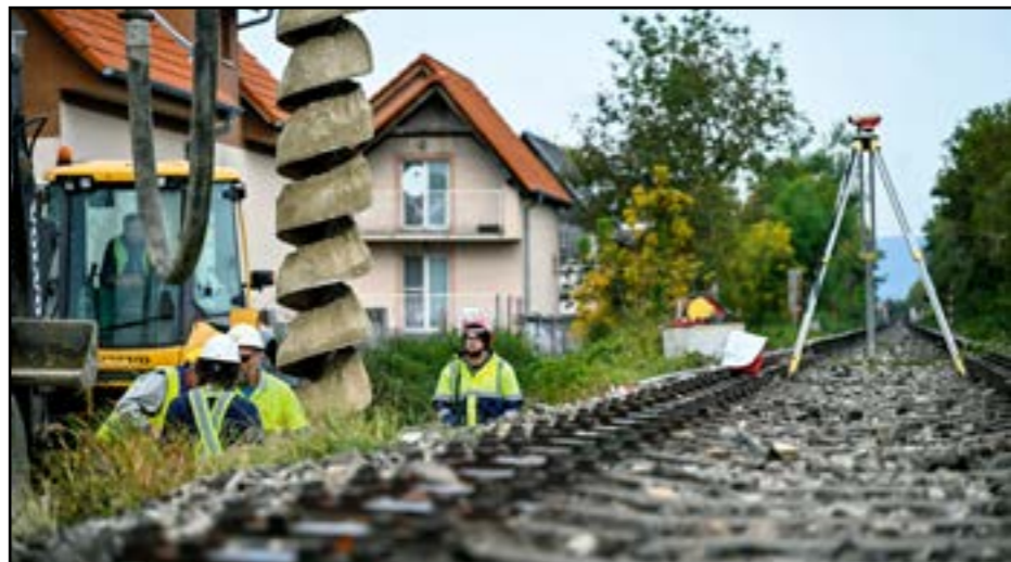
Práce na výstavbe terminálu sa začali v októbri.
