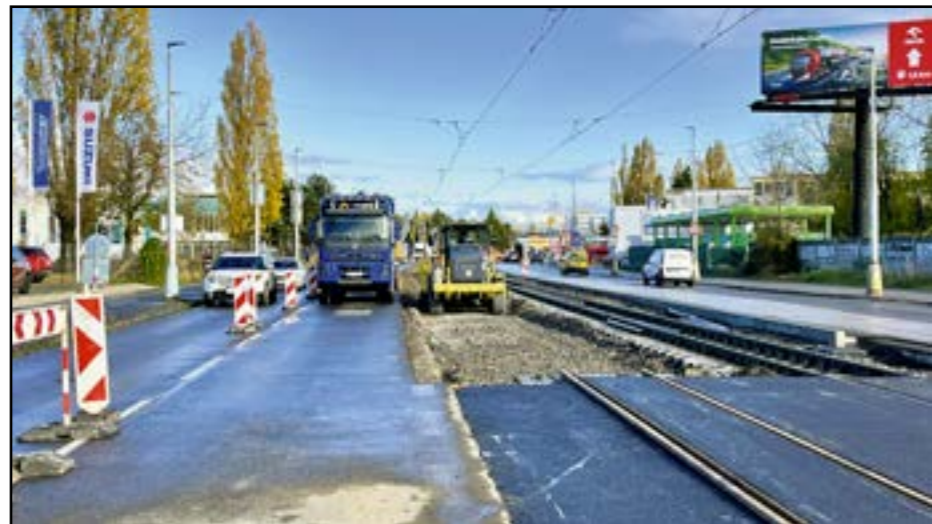
Oprava Vajnorskej radiály má byť ukončená v lete budúceho roku.
