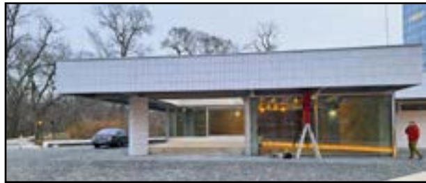
Budova bývalého erotického salónu krátko pred dokončením obnovy
