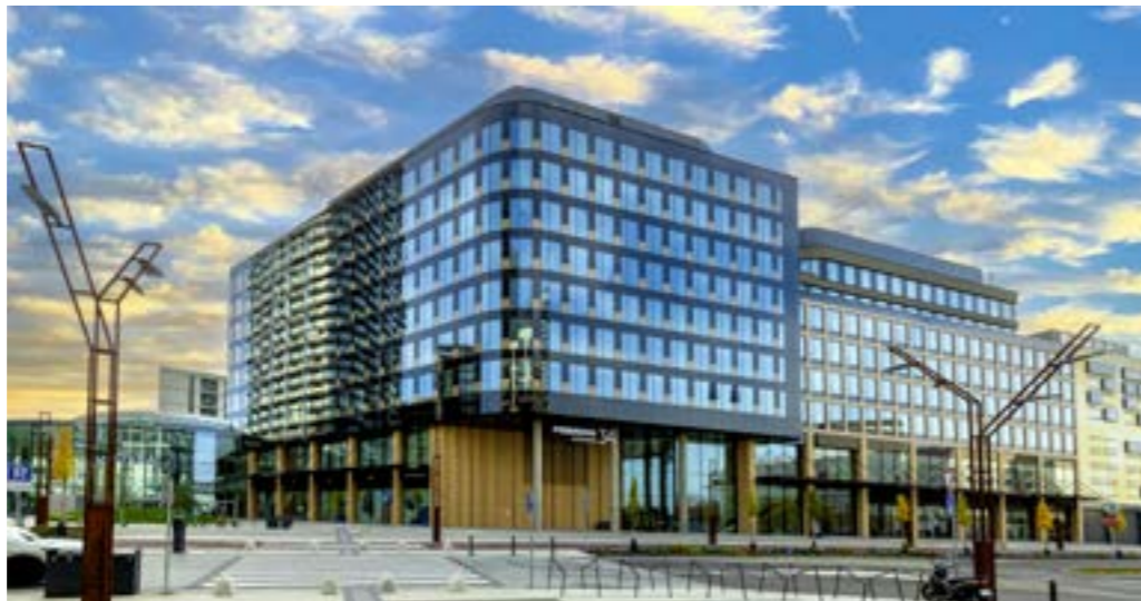
Kancelárska budova Pribinova 34 so zeleným certifikátom BREEAM Excellent disponuje flexibilnými priestormi s nízkou uhlíkovou stopou a je priamo prepojená s nákupným centrom Eurovea.
