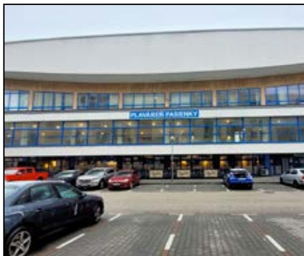
V ďalšej etape je v pláne aj rekonštrukcia vonkajšieho plášťa plavárne.
