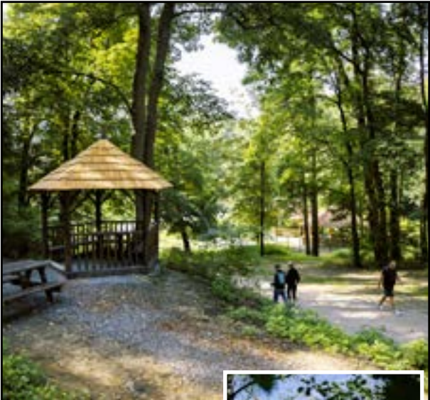
Asfaltovú krytinu na altánkoch nahrádzajú drevené šindle.
