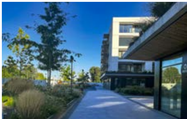
▲ Prevádzky v parteroch ešte nefungujú.
