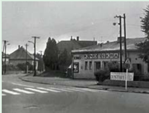
▲ Kino Iskra na Zväzackej (Štefánikovej) ulici pred asanáciou v roku 1982. Vybudované bolo v rokoch 1960–1961.
