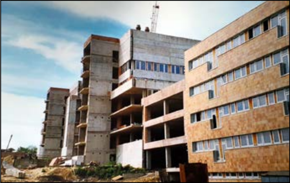
Nemocnica Rázsochy už mala podobu hrubej stavby s obvodovými múrmi, priečkami aj oknami, napriek tomu ju nikdy nedokončili.
