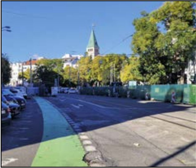
Práce na „trojnámestí“ sa začali v polovici októbra.
