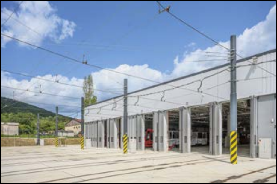
Tak, ako prebieha generačná obmena vozidlového parku, mení sa aj technické zázemie potrebné na jeho údržbu.
