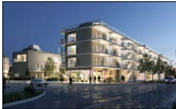
Pohľad na mestský bytový dom Terchovská z Galvaniho ulice
