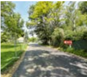
▲ Upravený povrch Májovej ulice
