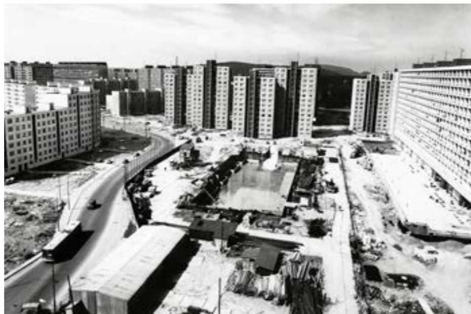
▲ „Červená“ pošta na dnešnej Furdekovej sa stavala v rokoch 1980 až 1984.
