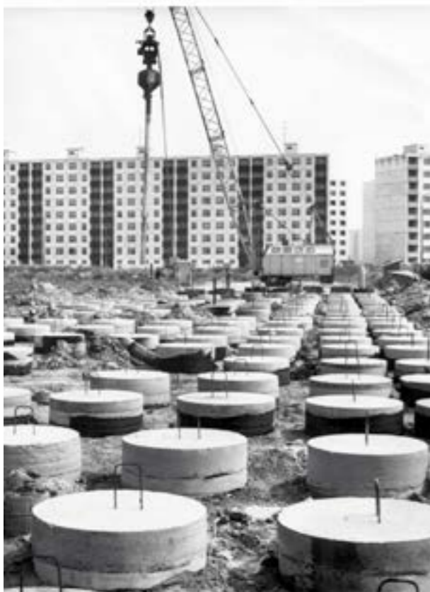
▲ 1983. Základy panelákov, ktoré boli nutné kvôli spodným vodám. „Takto sa v stredoveku stavali aj kláštory – na dubových pilótach,“ hovorí fotograf.
